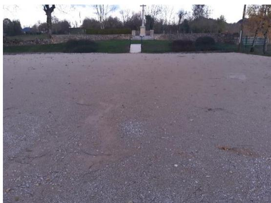
Un drainage s'imposait au bas du monument, s'en est suivie une réfection du terrain de boules (décaissage, enlèvement de la vieille surface, ensuite une mise en place d'un sol drainant avec un sable de finition). Nos amateurs boulistes ont apprécié cette nouvelle surface.
